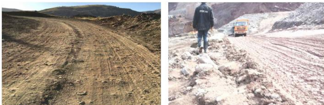
Рис. 3. Дорожные условия в горных карьерах при строительстве ГЭС: a – сухое дорожное покрытие с засыпанными абразивными породами; б – дорожное полотно, покрытое слоем грязи, содержащее высокую концентрацию абразивных частиц
